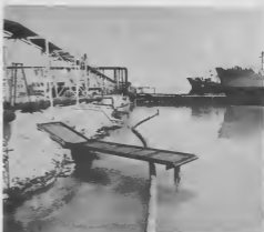
Pomp scoriador flotante cu un hoos flotante ta instala sitio di Finger Piernan.
